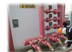
Subsurface injection หรือเรียกอีกอย่างว่า Base foam injection
